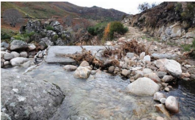
Figura 59. Detalle de la rotura de un paso de agua después de una avenida en el incendio de Xurés 2011. (Fotografía: Antonio Arellano).
